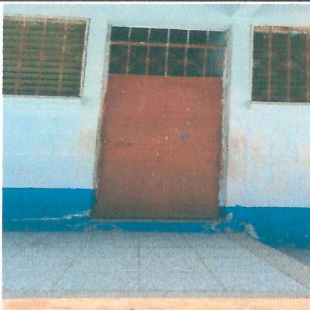
Foto 3: PINTURA EN PUERTAS
