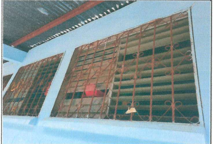
Foto 2: PINTURA EN BALCONES
