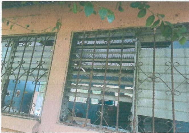
Foto1: MEJORAMIENTO DE VENTANAS
